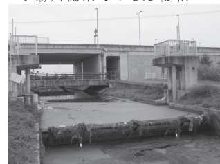
写真1 堰による滞留
